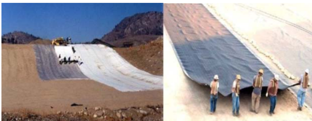
Слика 6.45. Постављање доње непропусне фолије
