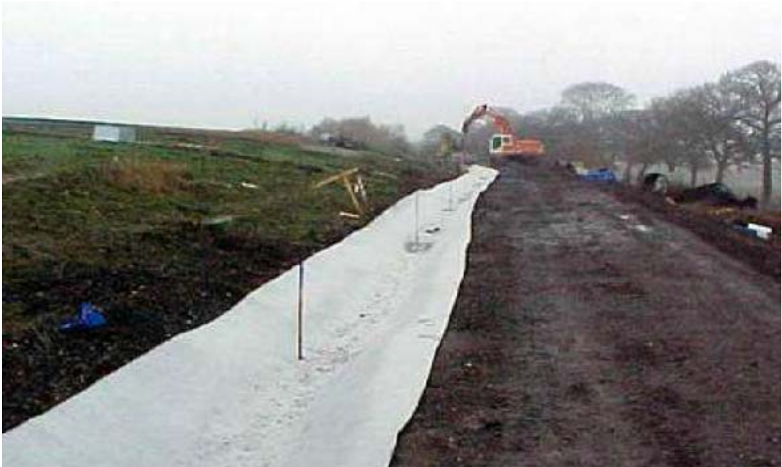
Слика 6.43. Приказ депоније са ободним каналима за отицање воде са фолије
